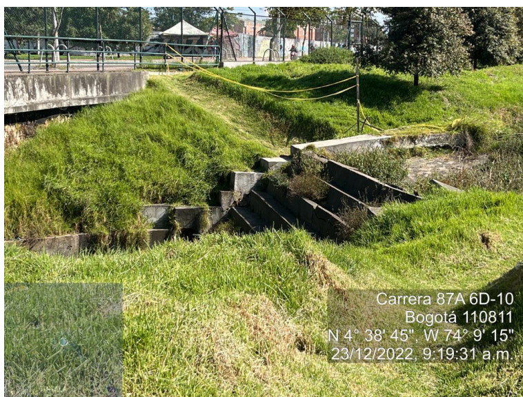
Figura 48. Fragmentación estructura disipación sector 4 humedal del Burro. Fotografía Tomada por Natalia Trujillo diciembre 2022.
